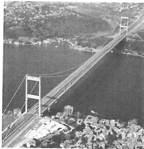
Deze brug hangt aan dikke ijzeren kabels. Ze houden de brug op zijn plaats.
